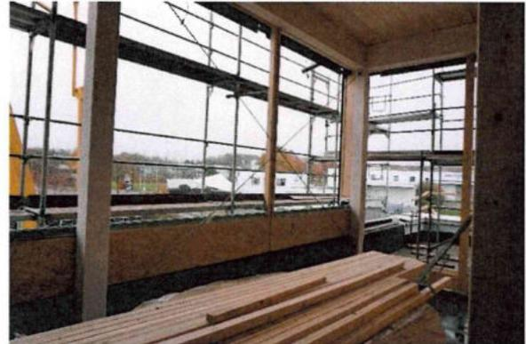
Die Außenwände und Decken werden außerdem überwiegend mit Holzwohle gedämmt, um im Sommer möglichst wenig klimatisieren und im Winter möglichst wenig heizen zu müssen. Extrem selten ist außerdem der Fahrstuhlschacht aus Vollholz. Üblicherweise werden solche Fahrstuhlschächte aus Beton hergestellt, dessen Herstellung sehr energieintensiv ist.
