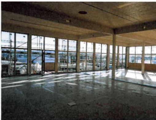
Beim Bau wird stark auf Nachhaltigkeit gesetzt: So wird vor allem Holz als Baustoff eingesetzt, was beispielsweise an der ökologischen Holzständer-Konstruktion deutlich wird.
