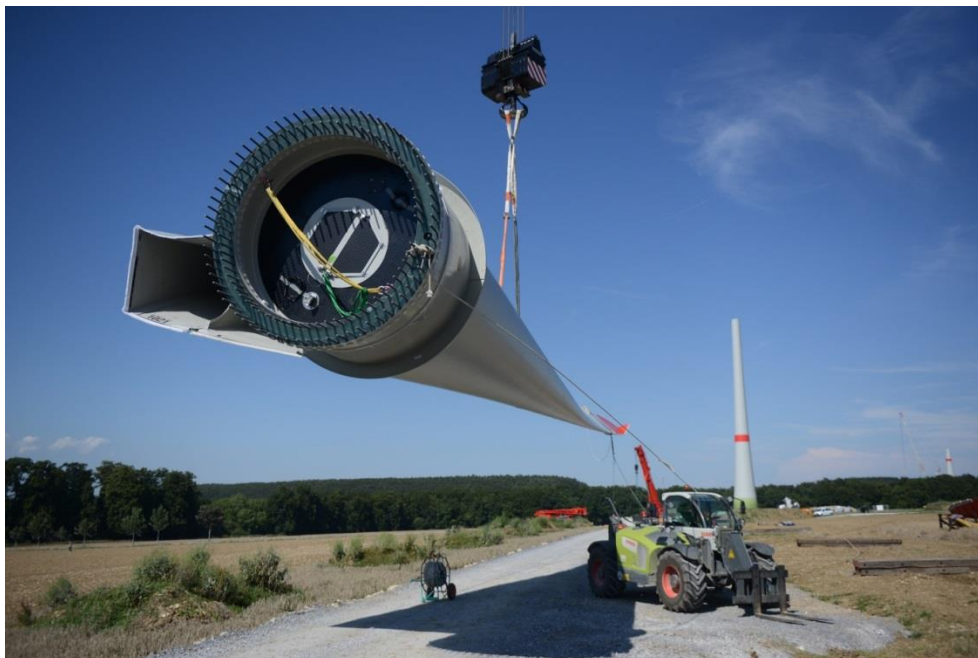
(*Bild 4: Windpark Huser Klee, Krantransport Rotorblatt)
